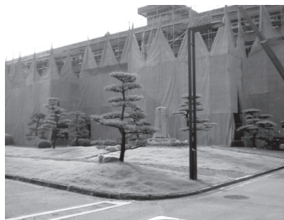
中庭からの改修工事風景
