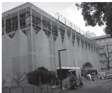
玄関からの改修工事風景
