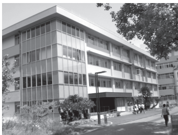
改修完了後の風景、玄関は自動ドアになった
