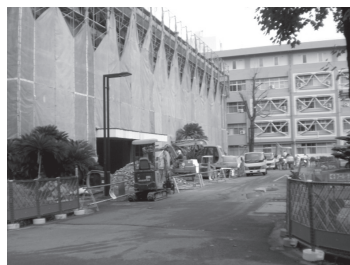
玄関からの改修工事風景
