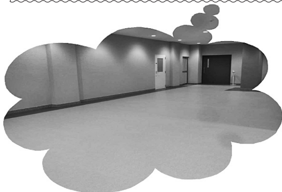
2号館1階エントランスの床
