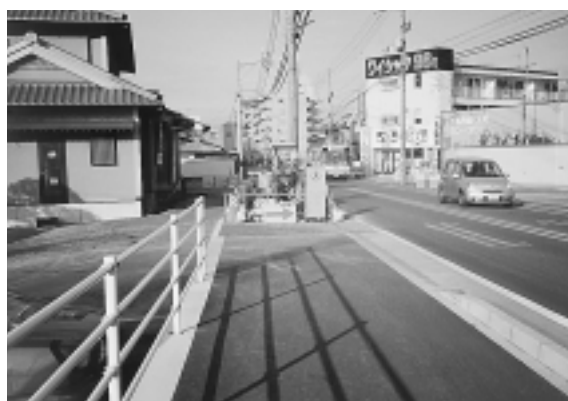
写真 - 7 歩道工事（温泉郡重信町）
