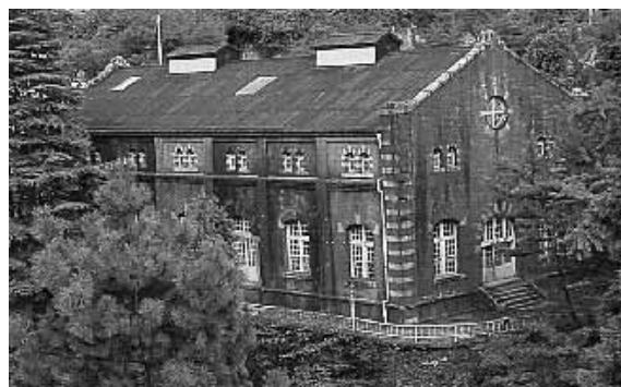
写真1 旧端出場水力発電所
