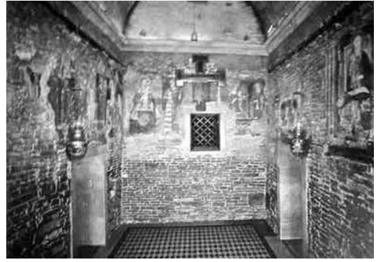
図 1 2 サンタ・カーザ内部、西壁面、ロレート大聖堂
