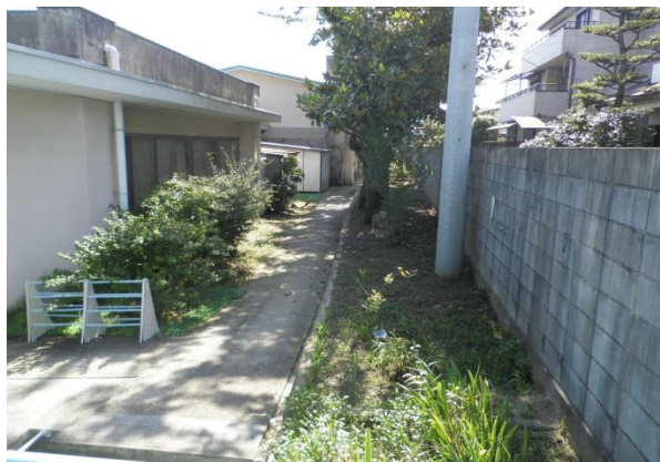
写真1 (改修前の園路の状況)
